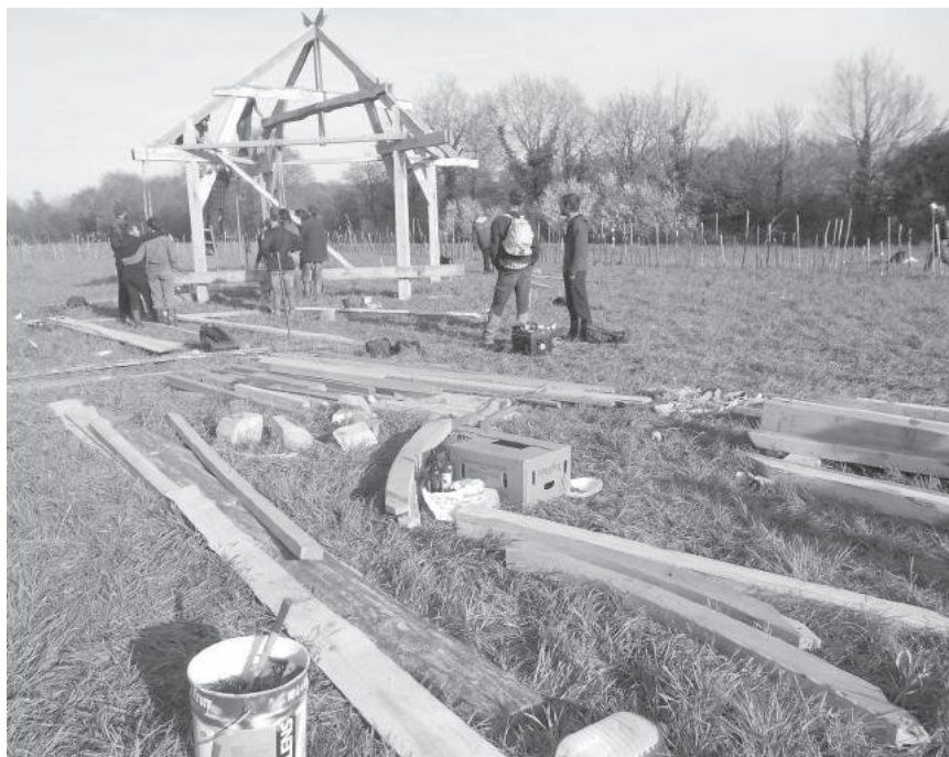
Chantier collectif à ND des Landes, en avril dernier
